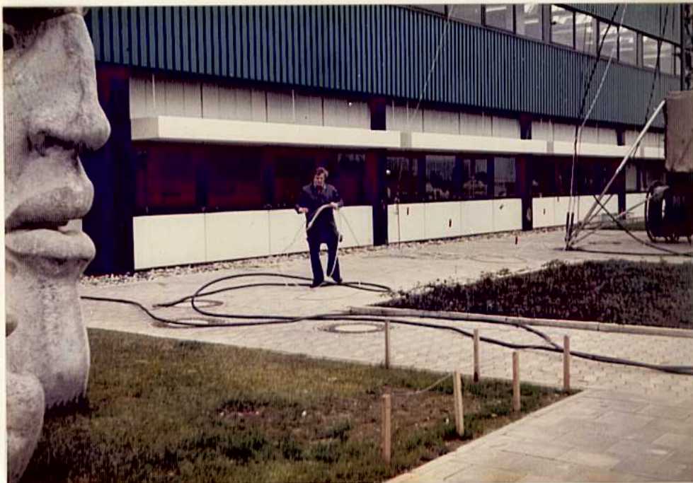
OM Runde beim Abbau der Antennenkabel
