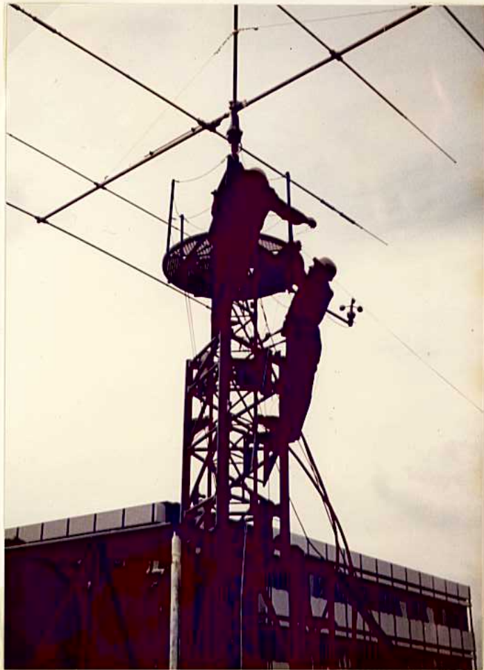
Abbau der Antennenanlage
